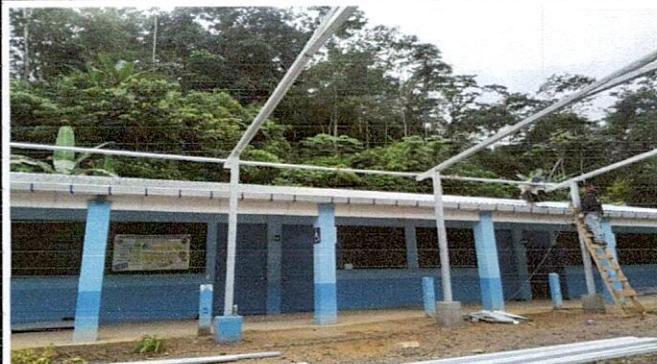
Foto 2: FINALIZACIÓN DE TIJERAS DE ENTECHADO GALVANIZADA 4X4 CHAPA 16
