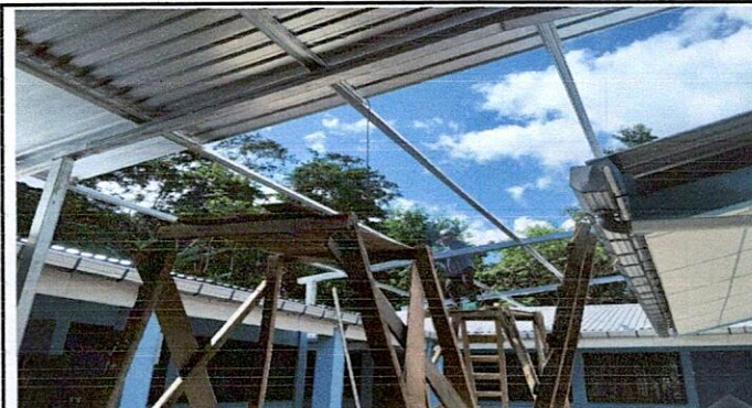
Foto 4: FINALIZACIÓN DE ESTRUCTURA METALICA PARA ENTECHADO GALVANIZADA 4X4X6 Y 2X4X6 DE CHAPA 16 DE 5X10 METROS, SUSTITUCIÓN DE MEJORAS DE LOS SERICIOS SANITARIOS
