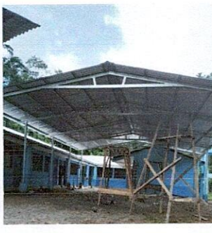
Foto 5: FINALIZACIÓN DE COLOCACIÓN DE LÁMINAS TROQUELADAS DE 23 PIES Y 18 PIES CALIBRE 26
