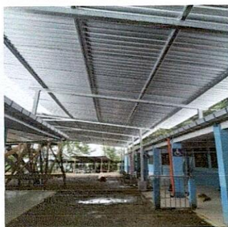
Foto 5: FINALIZACIÓN DE COLOCACIÓN DE LÁMINAS TROQUELADAS DE 23 PIES Y 18 PIES CALIBRE 26
