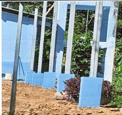
Foto 1: FINALIZACIÓN DE FUNDICIÓN DE BASES DE CONCRETO Y COLOCACIÓN DE BASES DE ESTRUCTURA METALICA GALVANIZADA FUNDIDAS
