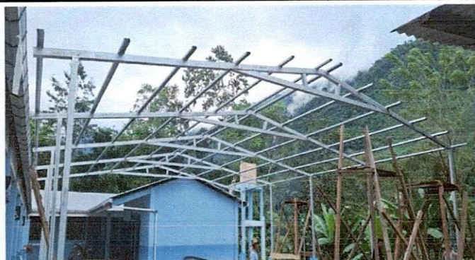
Foto 3: FINALIZACIÓN DE ESTRUCTURA Y ENTECHADO TIPO POLIDEPORTIVO
